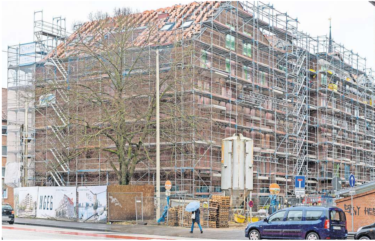
Ob das Fünfgiebelhaus in der Waitzstraße am Ende einen Biomarkt erhalten wird, ist weiterhin umstritten. Der Investor hält die Einwände der Stadt für unberechtigt.
