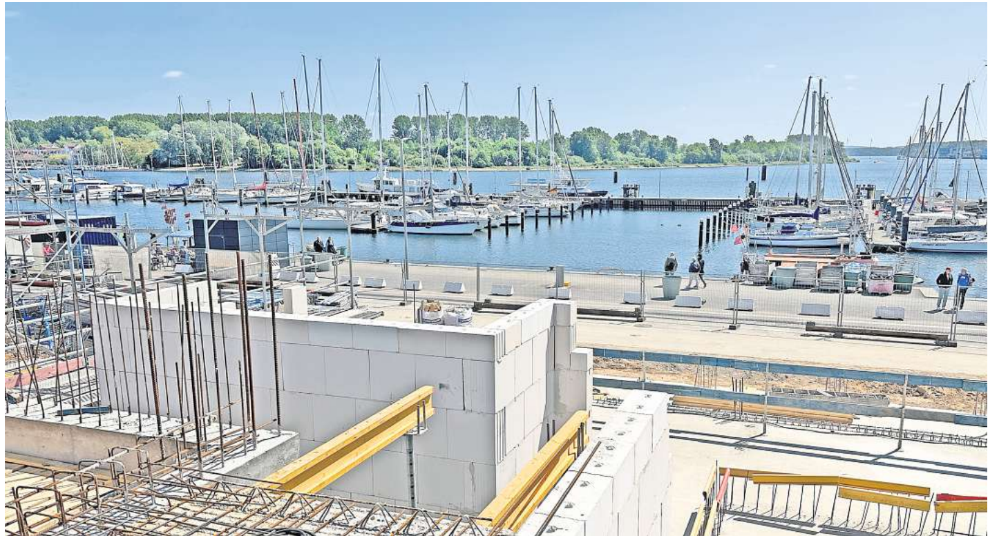
Noch ist am Fischereihafen eine Baustelle, doch bereits jetzt ist das einmalige Panorama von den Gebäuden aus zu sehen. FOTOS: THOMAS KROHN
